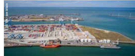
De haven van Zeebrugge
